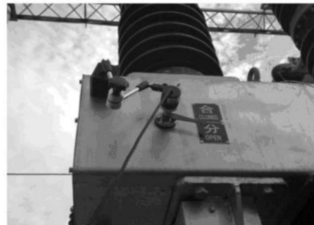
35KV SF6 开关传感器安装
